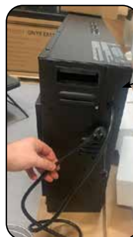
Faisceau de câbles et plaque de recouvrement réinstallés.
