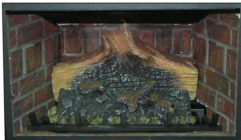
Figure 47. 4ème étape d'installation de l'ensemble de bûches.
