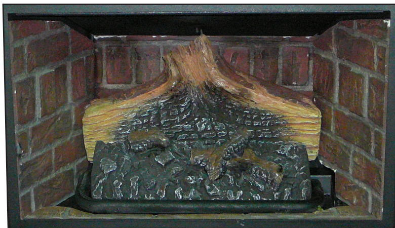
Figure 45. 2ème étape d'installation de l'ensemble de bûches.
