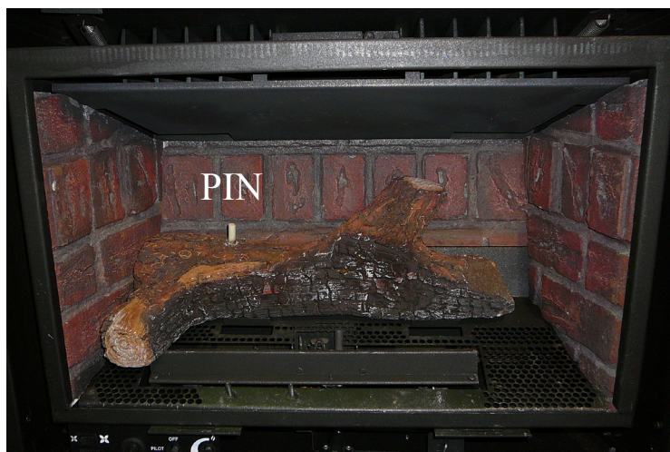
Figure 45. Premier étage d'installation des rondins.
