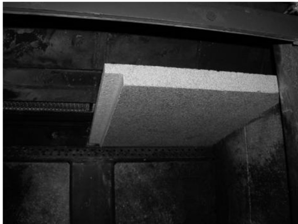
Figure 16 (cont.): Enlèvement et Remplacement du Déflecteur pour Inspection
