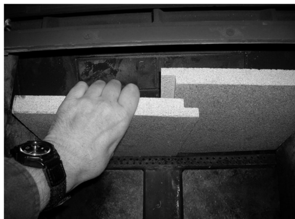
Figure 16: Enlèvement et Remplacement du Déflecteur pour Inspection
