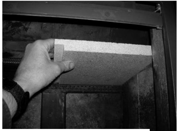
Figure 16 (cont.): Enlèvement et Remplacement du Déflecteur pour Inspection
