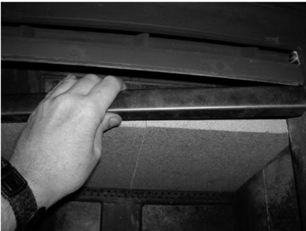
Figure 16 – Enlèvement/Remplacement du Déflecteur pour Inspection
