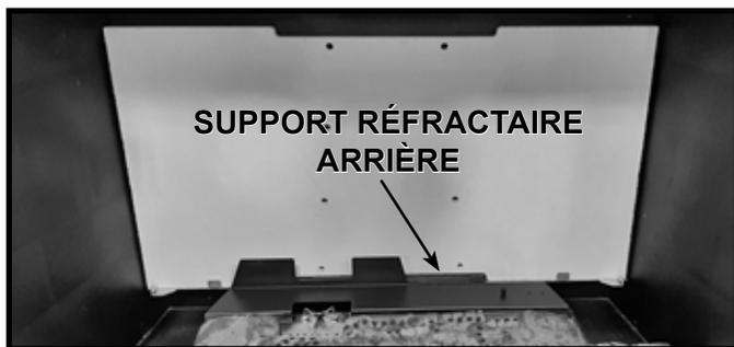
Figure 11.15 Panneau d'isolation arrière installé
