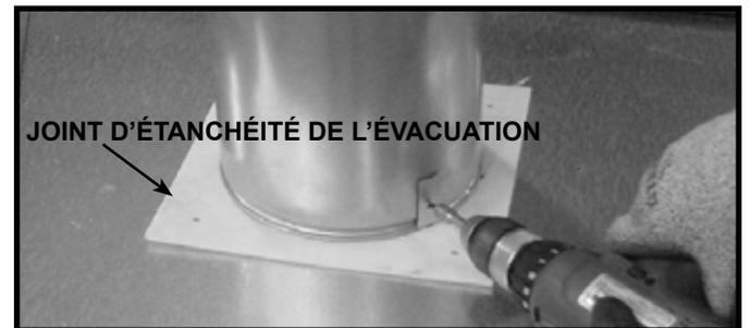
**Figure 6.6 (représentation d'un foyer générique)** Pour fixer la première section du conduit d'évacuation, assurez-vous d'utiliser le premier segment de l'évacuation se trouvant dans le sac manuel, pour sceller entre le premier composant et l'enveloppe extérieure du foyer. Vous pouvez sceller à l'aide de quatre vis ou d'un produit de calfeutrage ayant un indice d'exposition continue d'au moins 150 °C (300 °F) pour maintenir la pièce en place.
