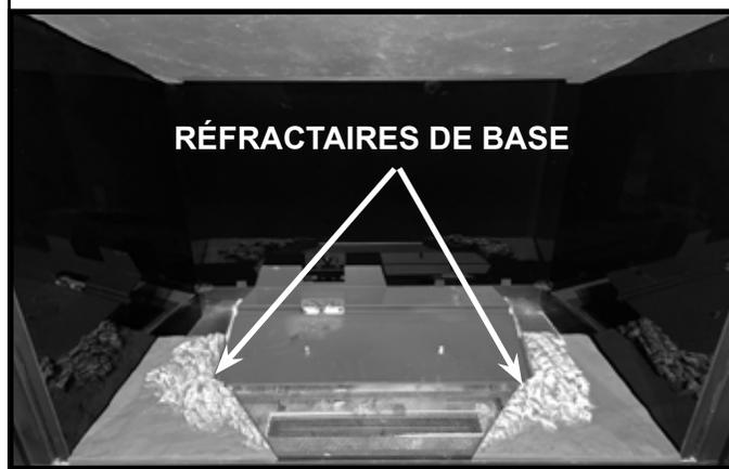
Figure 11.23 Réfractaire de base installé
