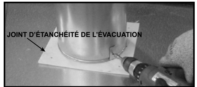
Figure 6.5 Retirez le panier d'isolation, l'isolation de l'évacuation intérieure et l'isolation de l'évacuation extérieure
