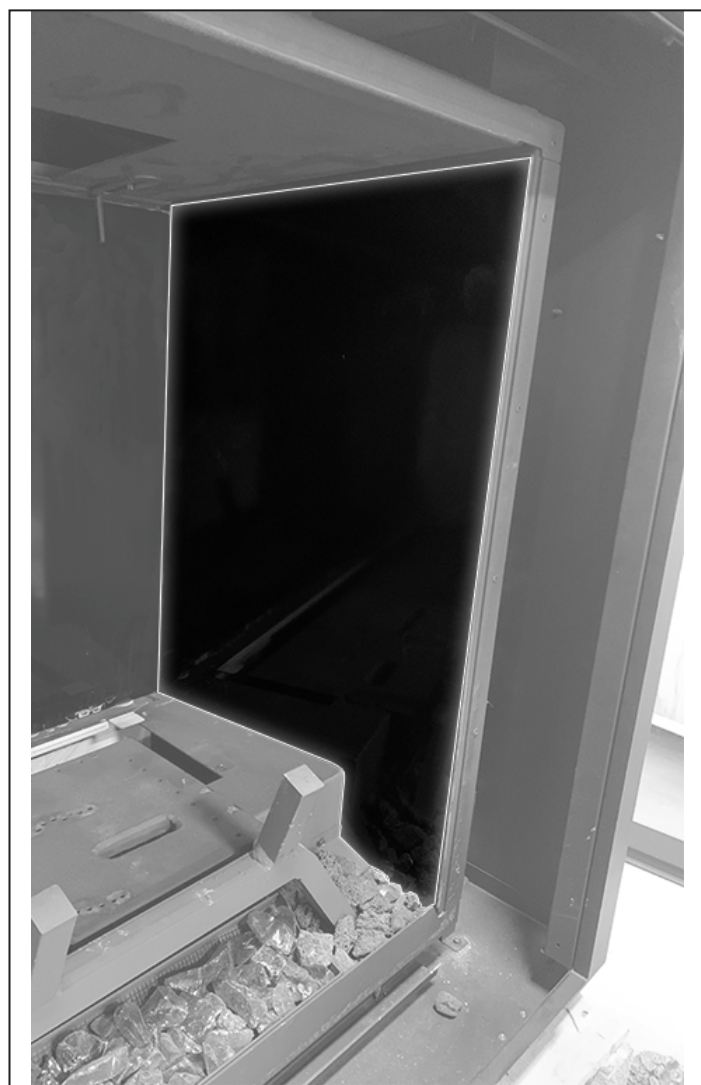
FIGURE 8.5 Panneaux latéraux en verre noir installés
