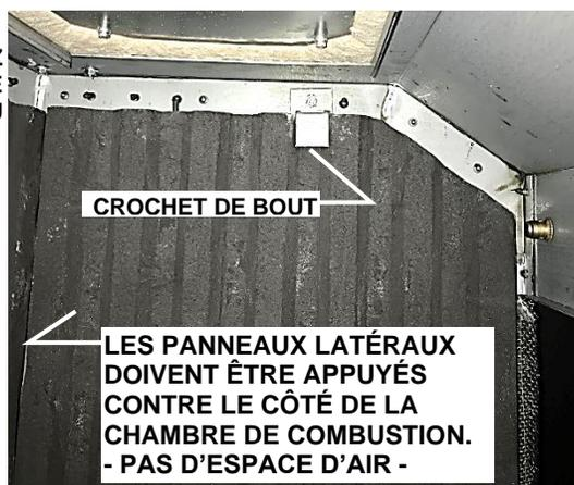
POUSSEZ DOUCEMENT LES PANNEAUX DE BOUT VERS LE BAS SUR LES TÊTES DE VIS
