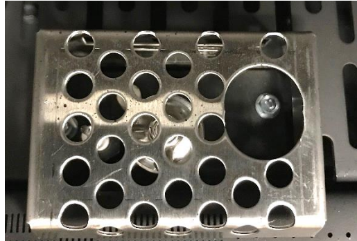
L'écran de la veilleuse doit être inspecté visuellement tous les mois pour déceler les signes de détérioration dus à l'exposition aux flammes. Remplacez si nécessaire.
