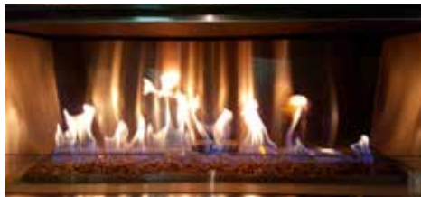
Apparence correcte des flammes
