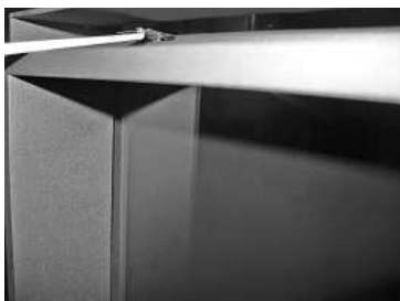
- Avec le crochet, en haut au milieu, enlever le mince languette-ressort métallique de l'ergot du cadre.
