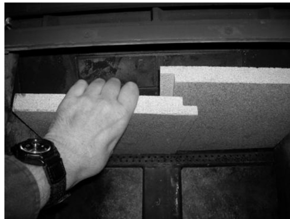
Figure 18 – Enlèvement/Remplacement du déflecteur pour Inspection
