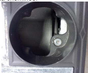
2. À l'aide d'une clé de 7/16 po, retirez les quatre boulons qui retiennent le collet supérieur du conduit de fumée à la fonte supérieure. Veillez à ne pas laisser tomber le boulon et les rondelles dans le poêle. Retirez la buse et placez-la sur le côté.
